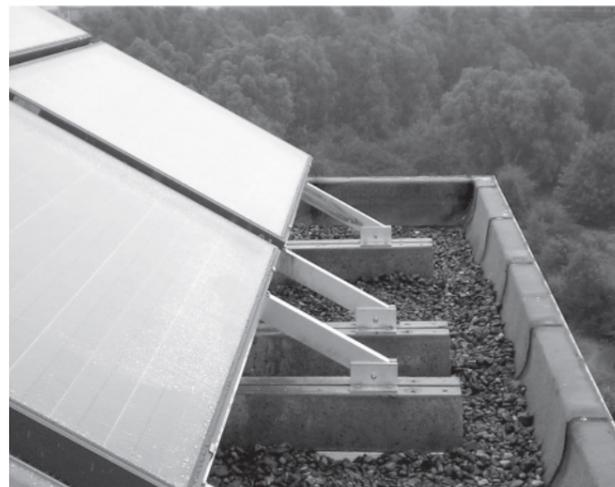
*Sur toiture étanche robuste: Si la structure du bâtiment est suffisamment solide vous pouvez fixer les châssis uniquement par lestage en utilisant par exemple des linteaux béton. Positionnez à même l'étanchéité un tapis...*
